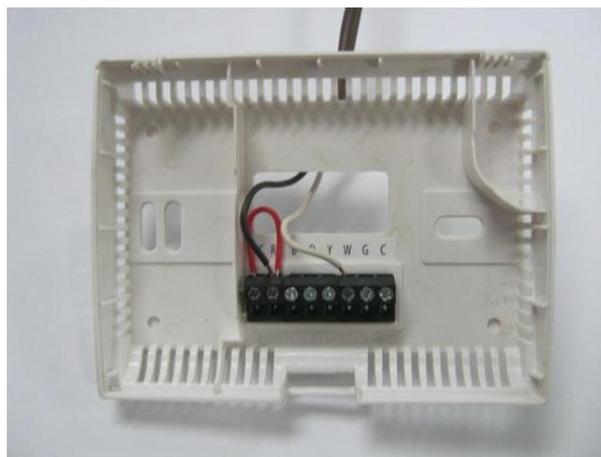
Raccorder un fil sur "RH" et l'autre fil sur "W". Le cavalier rouge peut être laissé en place. Pour de plus amples informations, se référer aux instructions du fabricant du thermostat.
